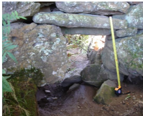
Figura 5 - Dreno quadrangular com vala com seção retangular Foto: A autora. Data: 05/02/2008.
