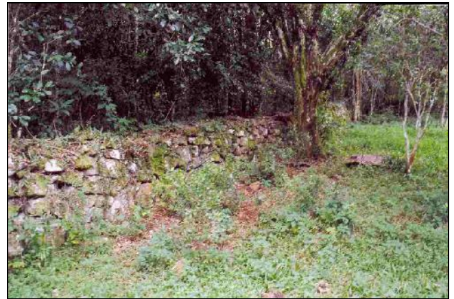
Figure 4 : Mur d'enclos pour les animaux, bâtiment de péage de Santa Vitória .
