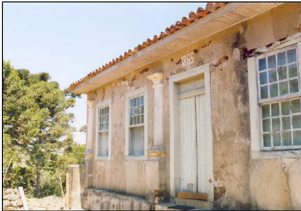
Figure 5 : Façade du bâtiment résidentiel de la ferme Cajuru .
