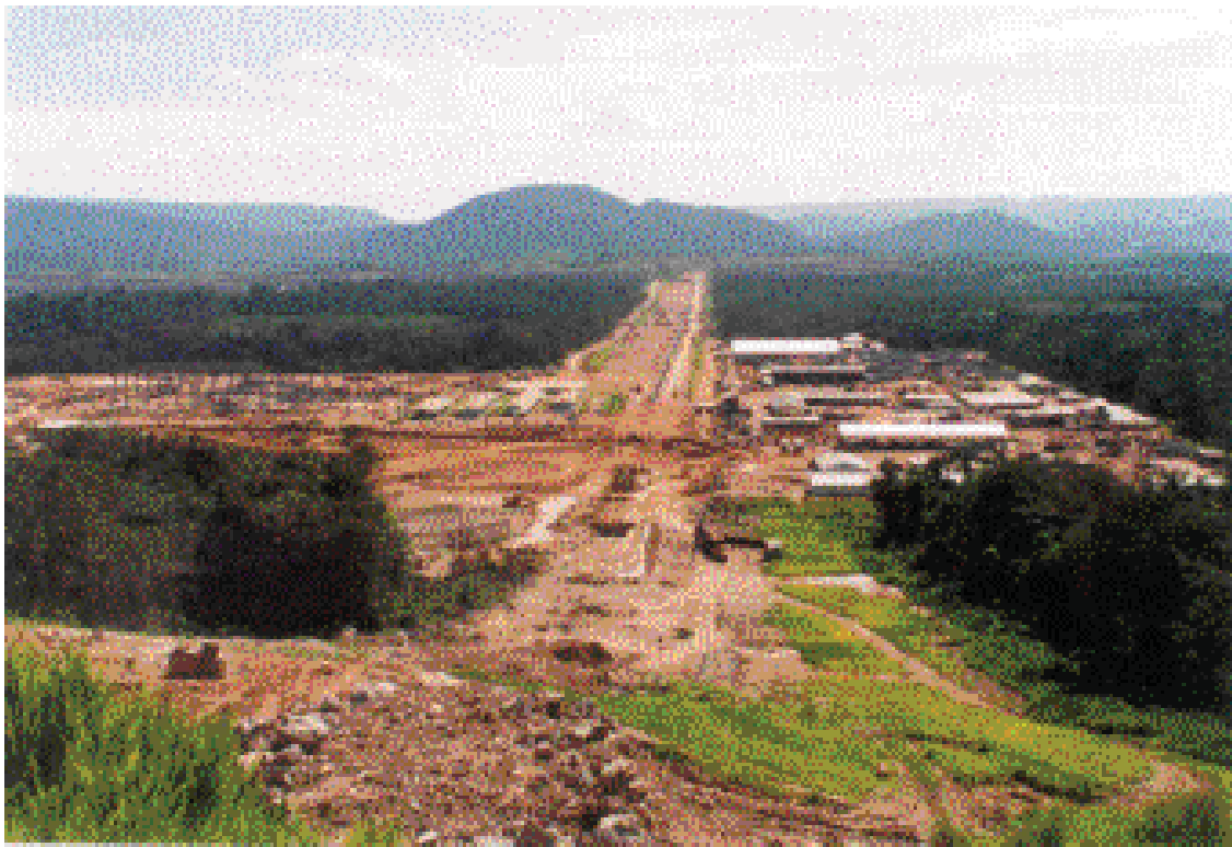
Foto 1 - Infra-estrutura da Mineração Serra do Sossego (PA): à direita, canteiro de obras das empresas terceirizadas; à esquerda, escritórios da parte administrativa e estruturas de beneficiamento em construção; ao centro, correia transportadora de minério. Foto: Paula Sampaio.
