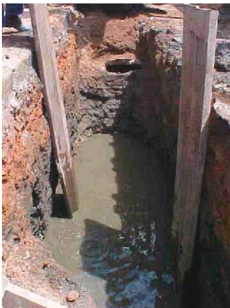
Fotos 15 e 16 - afloramento do lençol freático, associado a vazamento da rede de esgoto, na Rua Antônio Rayol, sendo a lama contaminada retirada diretamente para as caçambas, onde os arqueólogos procuraram recolher o material passível de recuperação.
