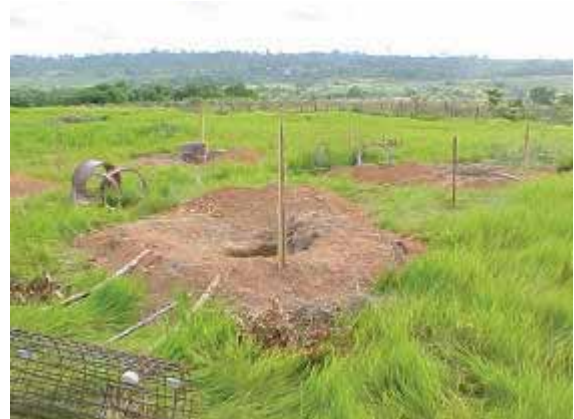
Foto 5: : impacto gerado por fundação de torre estaiada.
