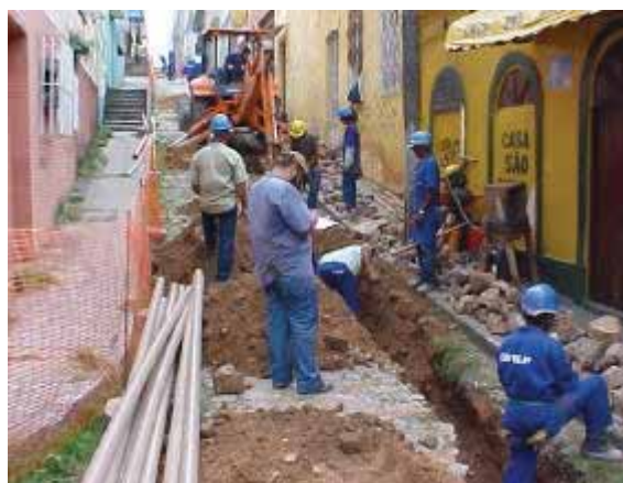
Foto 12 – Monitoramento das obras na Rua Godofredo Viana, entre Rua de Santana e Beco Escuro.
