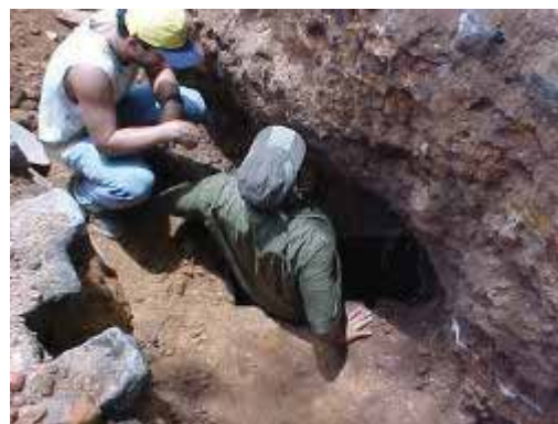
Foto 11 - Inspeção de uma galeria antiga, evidenciada pela retroescavadeira (Av. Magalhães de Almeida, entre Rua Direita e 14 de Julho).
