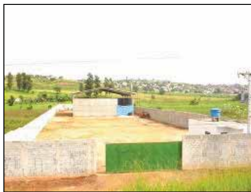
Foto 18 - Área de implantação de Empresa de Tratamento e Recuperação de Resíduos de Fundição de Alumínio em Itaquaquetuba, SP, totalmente terraplenada e murada.
