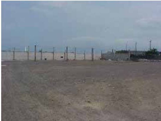
Foto 20 - Área do empreendimento, totalmente terraplenada
