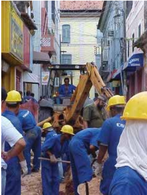
Foto 14 - Atividades desenvolvidas no turno da noite, destacando-se a ação da retro-escavadeira e a dificuldade da vistoria arqueológica devido à iluminação insuficiente no local (Rua Grande, entre Rua de Santa Rita e Rua da Mangueira).
