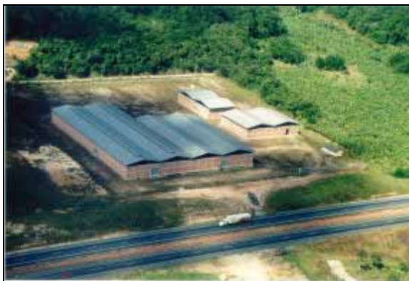
Foto 17 – área de implantação e Plataforma de Tratamento de Resíduos Industriais em Juquiá, SP, já totalmente terraplenada e com edificações.
