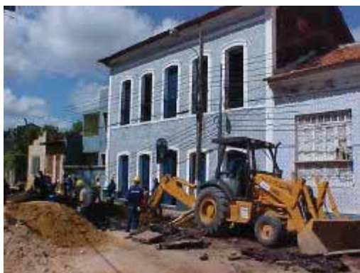
Foto 10 - Escavação manual e mecânica da vala nas proximidades de um casarão colonial
